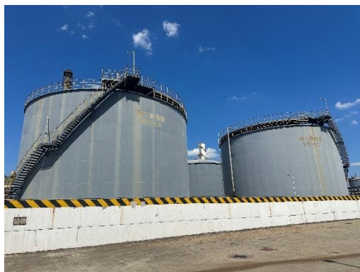
硫酸罐区围堰
