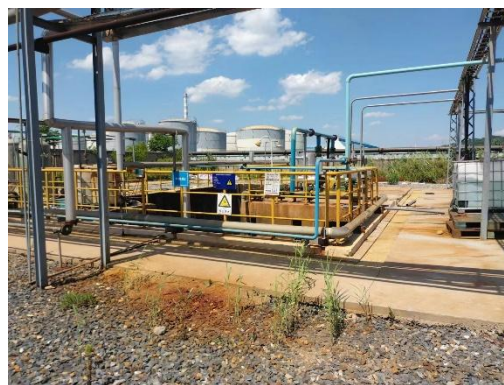
南厂区硫酸中和污水池
